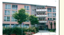
Altenhilfezentrum Wiesengrund, Aalen
